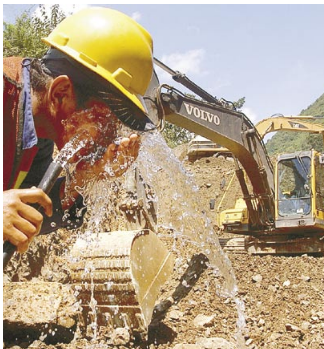
Los operarios de Inviás laboran en dos frentes durante las 24 horas del día para evacuar las 40.000 toneladas de piedra y lodo que dejó el derrumbe del kilómetro 54. JOSÉ LUIS GUZMÁN | El País
